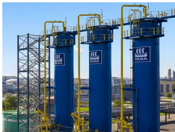
24メガワットのプラチナベースの電解施設であるグリーン水素試験工場は、Linde Engineering が設計士建設する2番目の工場となる。写真提供: Yara
